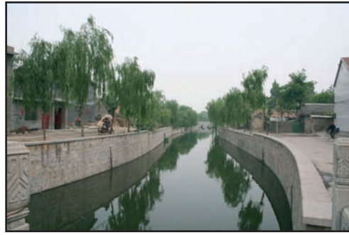
Les douves rénovées
