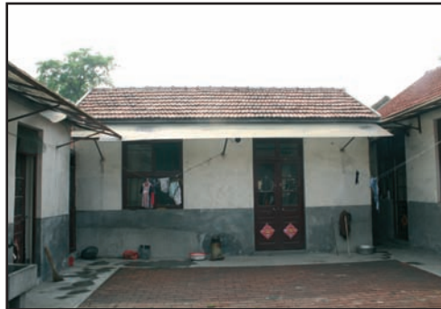
Exemple d'auvents installés par des habitants
