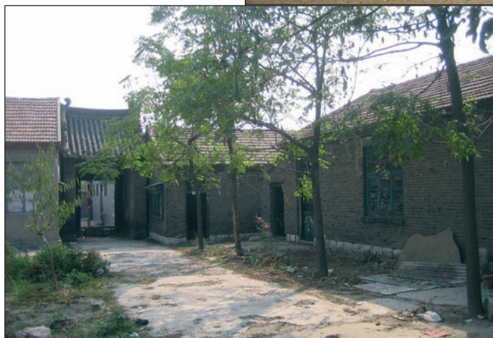
Le porche avant travaux
