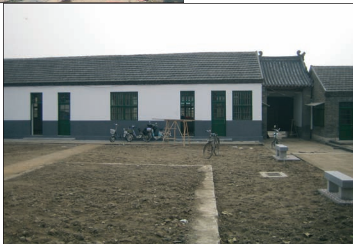
Porche et bâtiment sud après travaux
