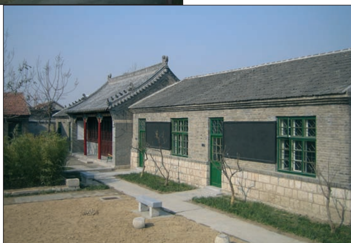
Salle de cours avec tableaux noirs extérieurs après travaux
