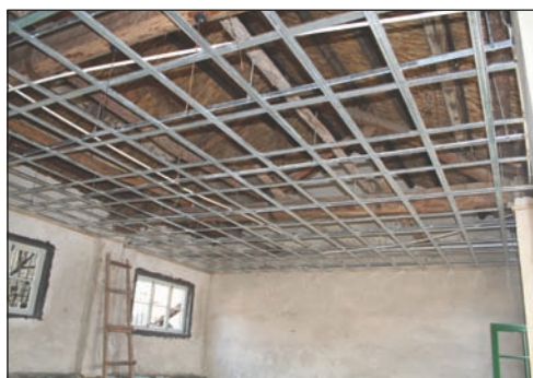
Isolation du plafond
