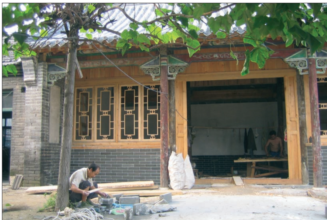
Rénovation de l'ancien temple
