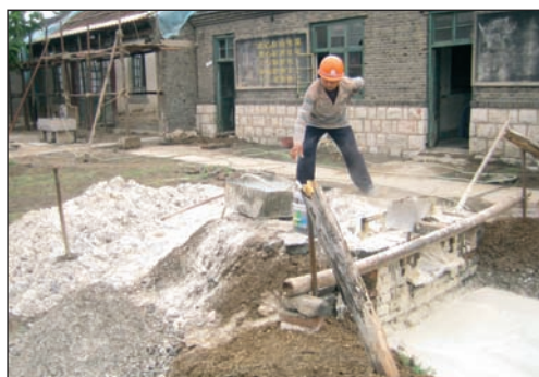
Préparation de la chaux
